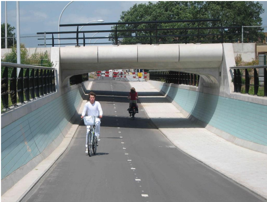
Unterführung Radschnellweg in Zwolle (NL)
